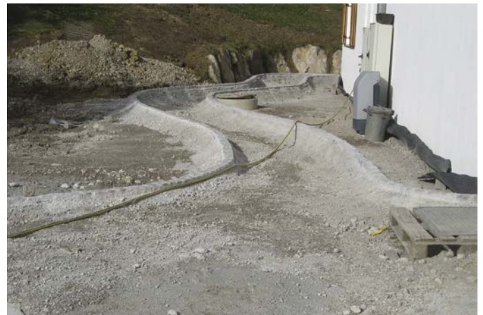
Die Wegeführung um das Gemeinschaftshaus nimmt bereits Formen an
