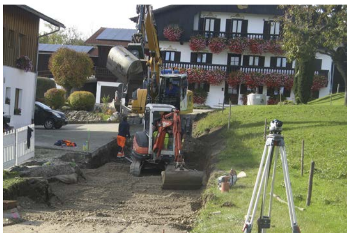
Gleich mehrere Bagger sind bei den Tiefbauarbeiten am Römerring im Einsatz
