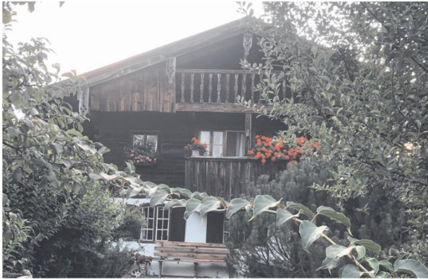
Den baulichen Charme der Dörfer bewahren, sich aber auch moderner Architektur nicht zu verschließen – darum geht es der Gemeinde Bad Feilnbach als Mitglied der Baukulturregion Alpenvorland. Eines der ältesten Häuser im Landkreis Rosenheim ist das Schneiderhäusl in Kutterling. Es stammt aus dem 16. Jahrhundert. FOTO: BAUKULTURREGION VORALPENLAND
