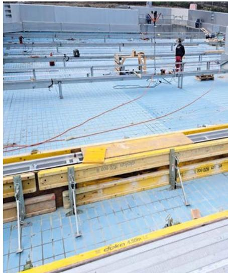
*Erstellen einer Schalung zum Betonieren.*
